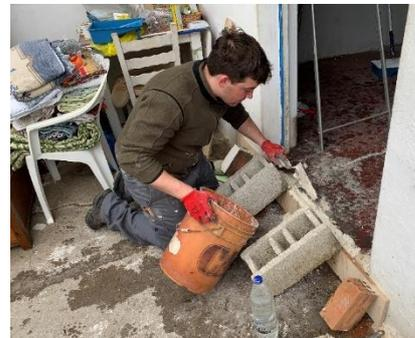
Abbildung 10: Michi zementiert die Stufe
